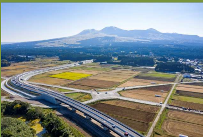
国道57号北側復旧道路
