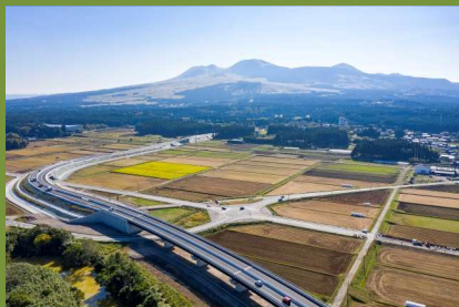
国道57号北側復旧道路
