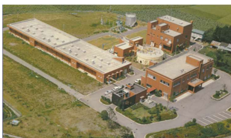
下水道処理施設
