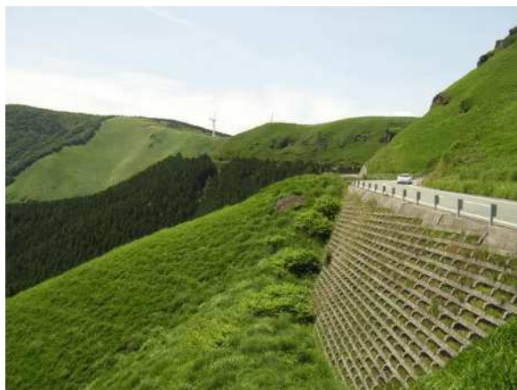
擁壁に緑化を図った例 (阿蘇市)
