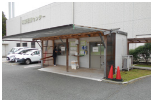
仮設のコンテナを設置して新型コロナウイルスの対応にあたった
